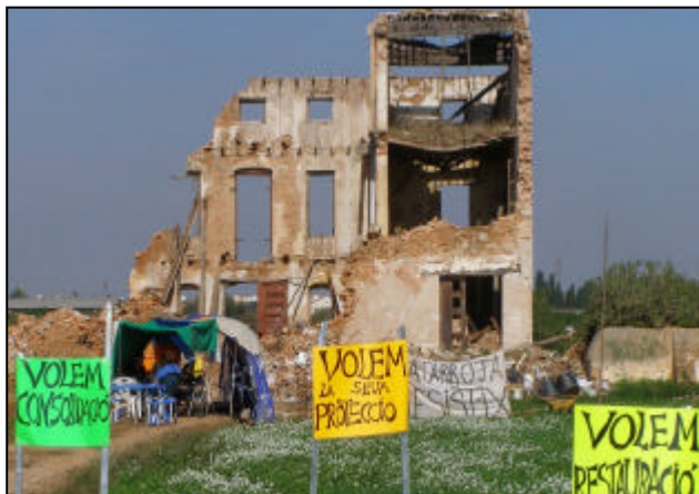
Imatge de la façana de l'alqueria parcialment enderrocada el passat 11 d'octubre.
